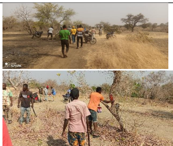
Photo 15 : Marquage et ouverture des limites du corridor n°2 dans la zone de Zabré, Mars 2025, par A W Nikiéma
